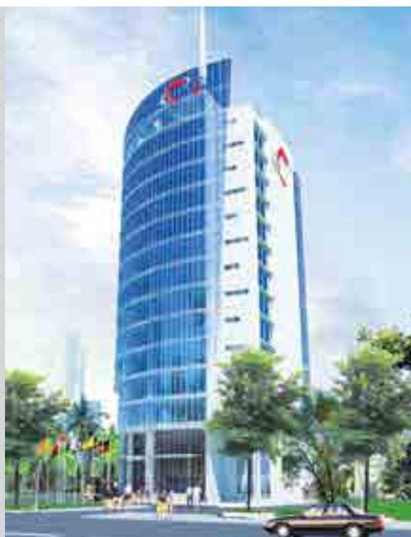
Tòa nhà trụ sở Coteccons
