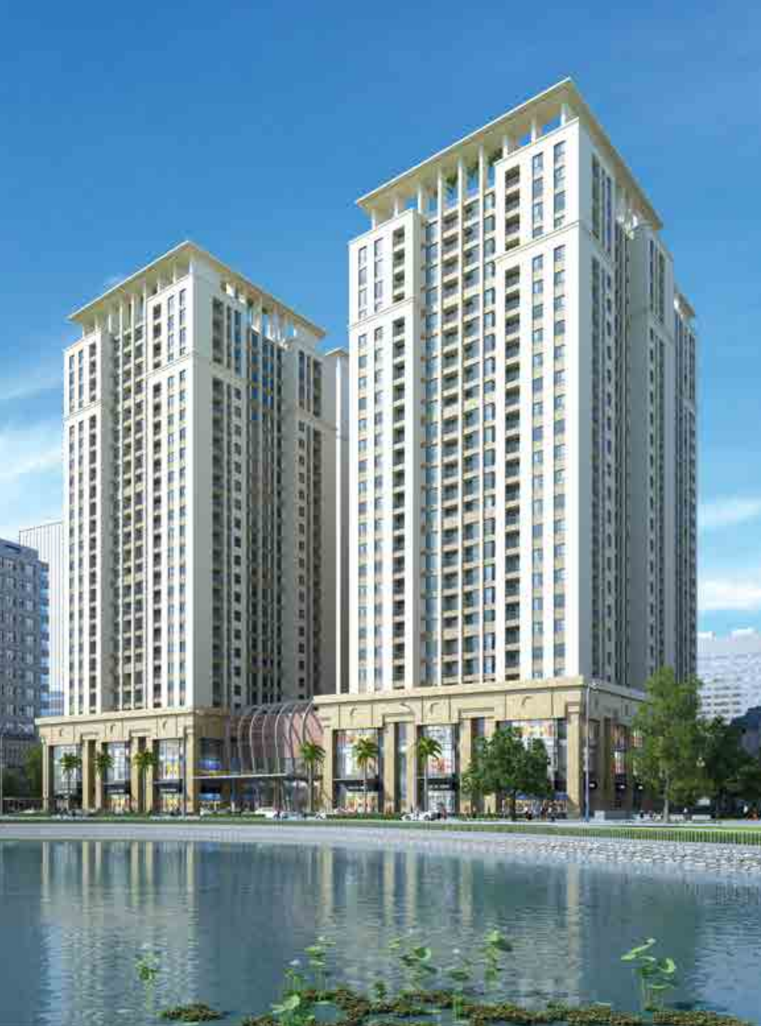
Khu chung cư Trung Kính Complex - Hà Nội
