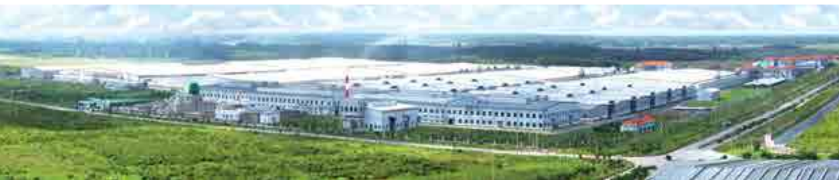
Nhà máy Brotex - Tây Ninh
